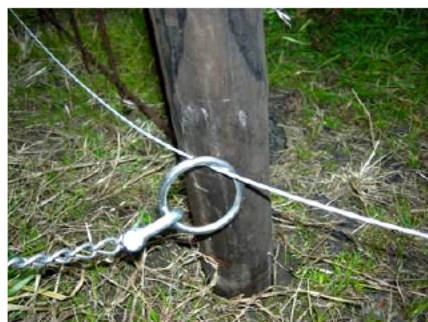
鋼線とリングの連結状況
