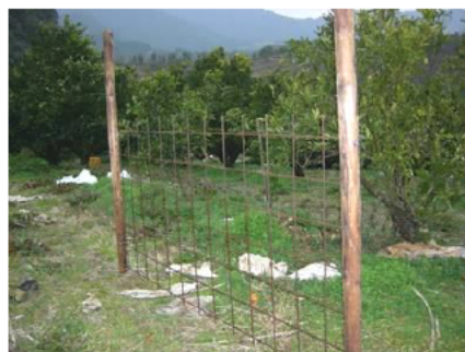
杭とワイヤーメッシュの設置状況
