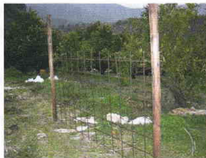
杭とワイヤーメッシュの設置状況
