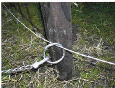
鋼線とリングの連結状況
